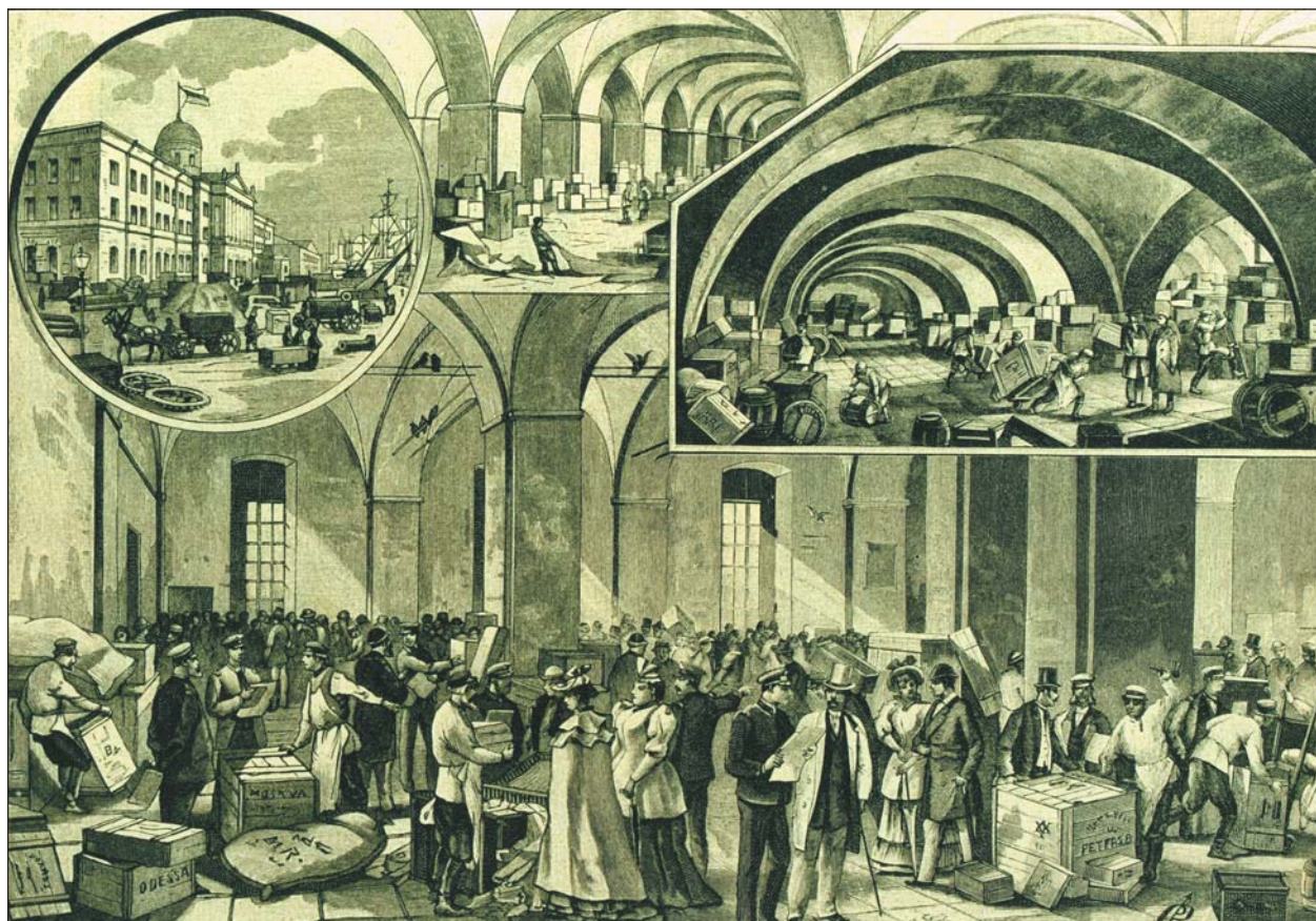
Санкт-Петербургская торговая таможня. Осмотр товаров. Вверху: слева — общий вид здания, справа — кладовая. Гравюра из журнала «Нива» (1894. №2. С.41).
